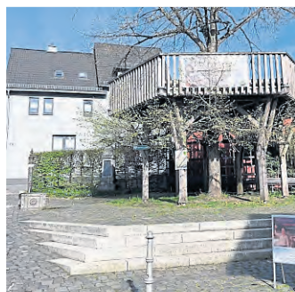
Sanierungsarbeiten der Treppenanlage an der Linde in Bärstadt starten ab 05. Mai 2026.
